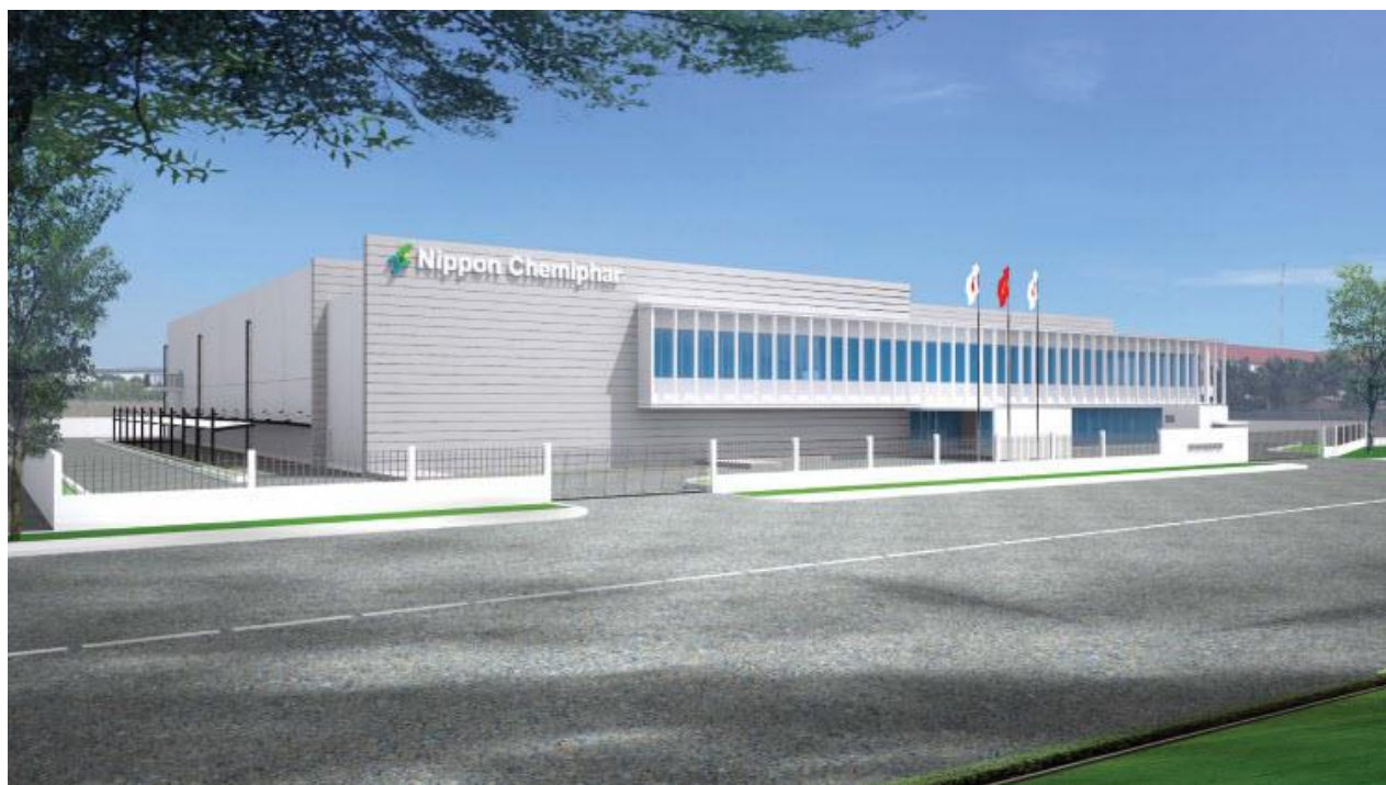
Nhà máy Nippon Chemiphar - KCN. Vsip Bình Dương
