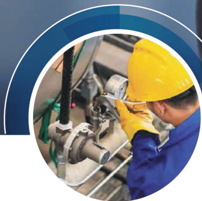
Bảo dưỡng, bảo trì hệ thống cơ điện toàn nhà máy
